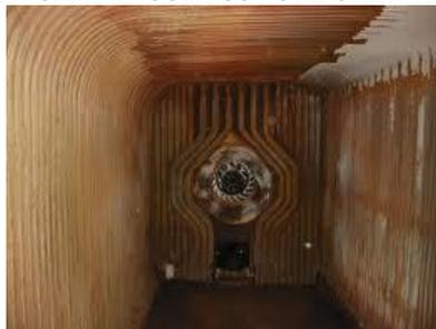
Nella camere di combustione delle caldaie a condensazione si producono spesso incrostazioni di residui fuliginosi dovuti alla combustione. L'uso di prodotti specifici contribuisce efficacemente alla pulizia. A tale scopo, l'impiego di EURO 810 parte A e parte B migliora la funzionalità e il rendimento della caldaia stessa
